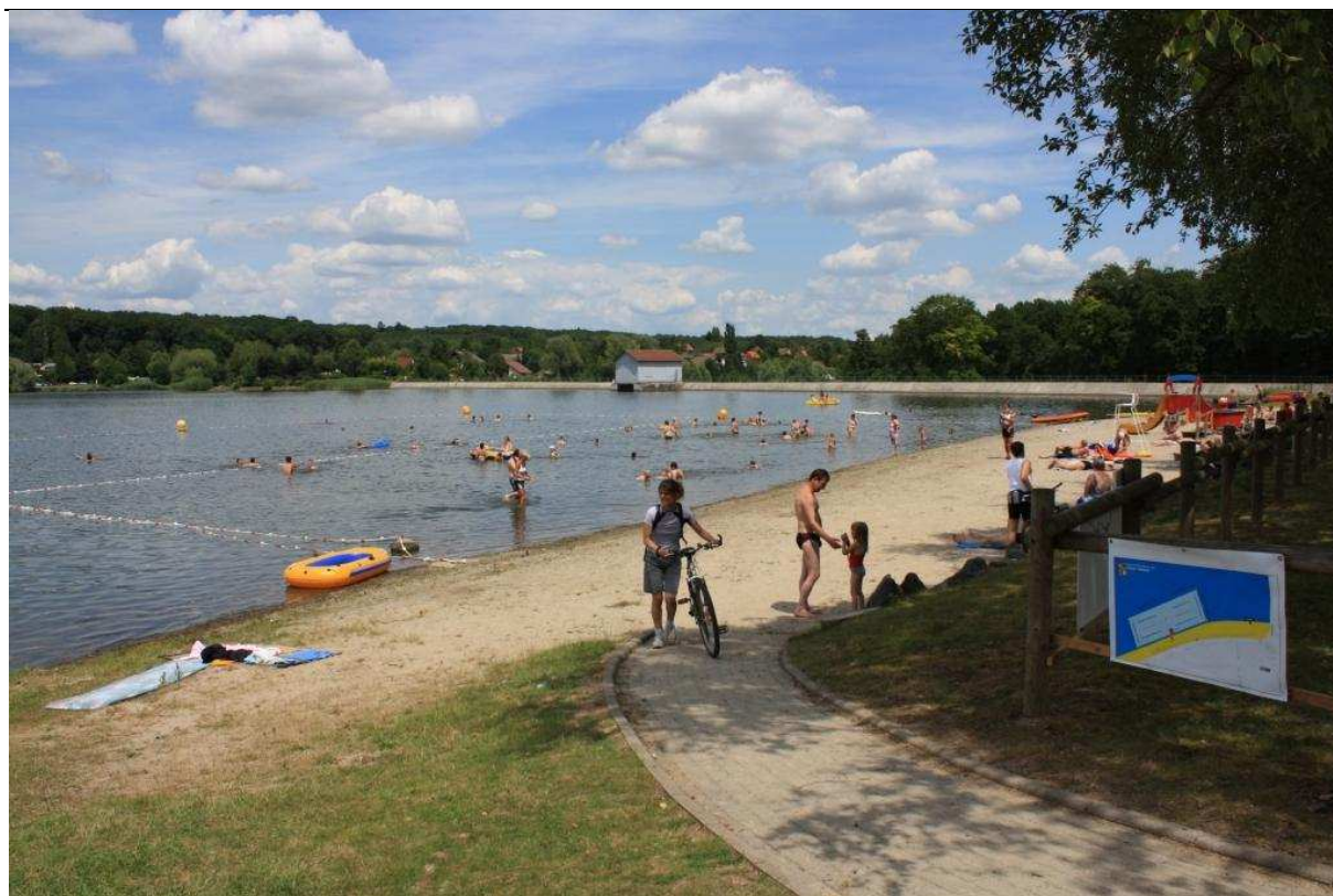
Figure 10 : photographie de la digue vue depuis la zone de baignade
